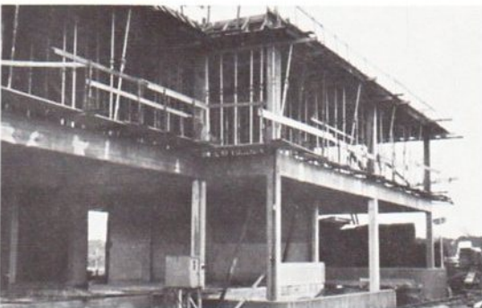
Abb. 1 Rohbau eines neuen Schulgebäudes.
